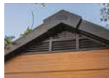
Fori di ventilazione
