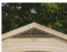
Fori di ventilazione
