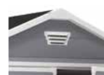
Fori di ventilazione
